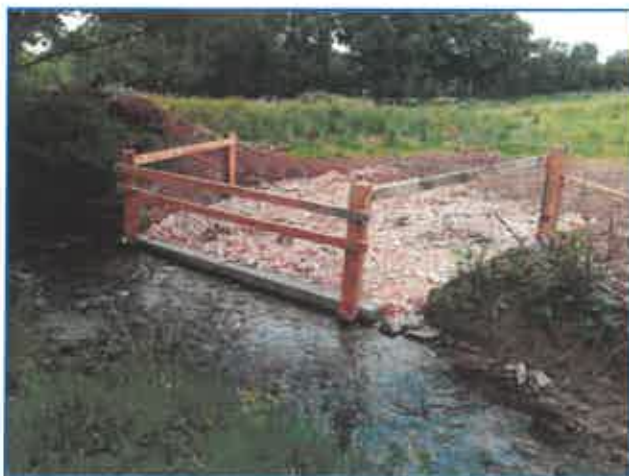
Figure 3 : Photo exemple d'une descente aménagée sur la Douve dans la maîtrise du piétinement bovin
